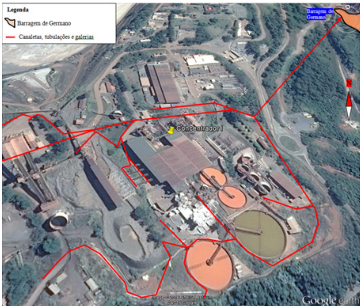
Sistema de drenagem pluvial do Concentrador 1 Fonte: Google Earth.
