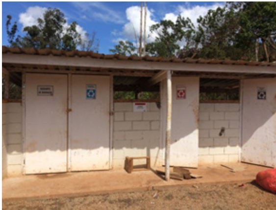
Depósito intermediário de resíduos implantado no canteiro de obras adjacente à Barragem de Nova Santarém Fonte: Samarco, 2016.
