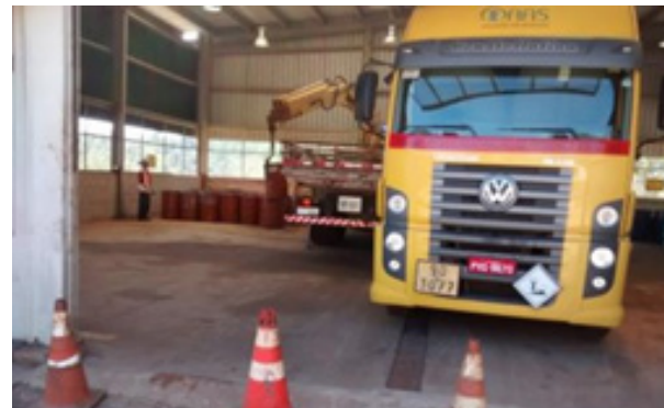
Vista geral do depósito de resíduos oleosos Fonte: Samarco, 2016
