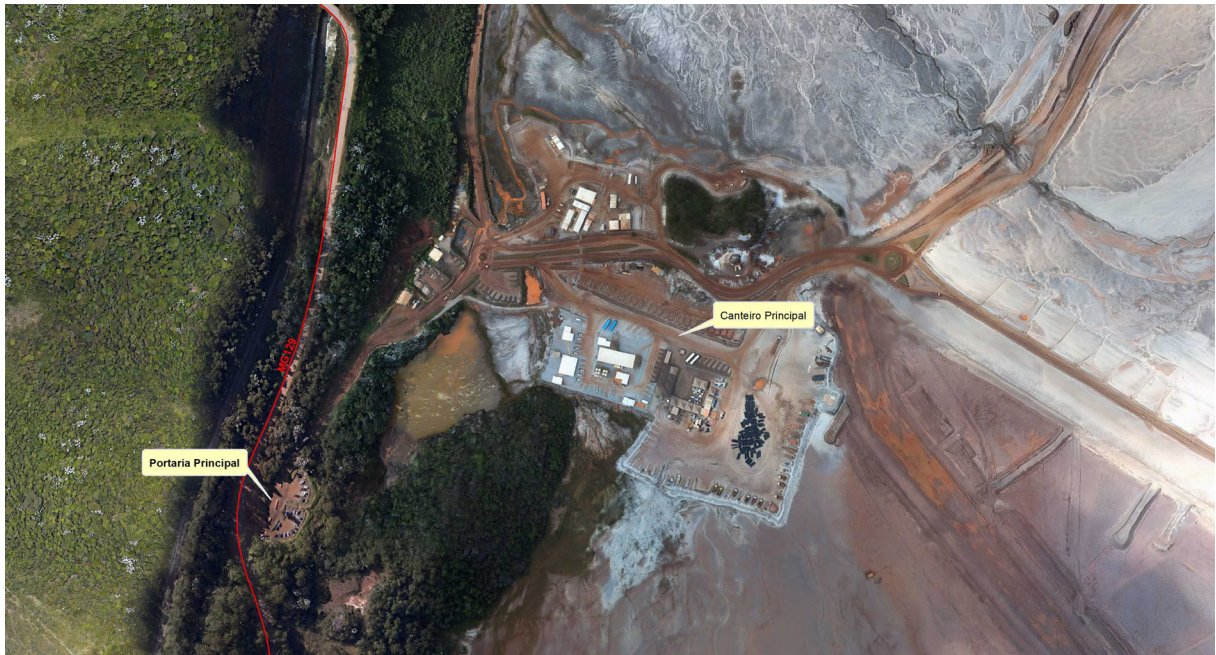
Vista geral dos Canteiros Principal e Pátio de Estoque 2 Fonte: Samarco, 2016.
