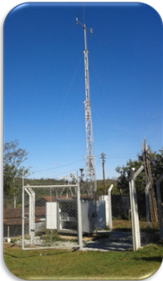
Estação de monitoramento de qualidade do ar de Santa Rita Durão.
