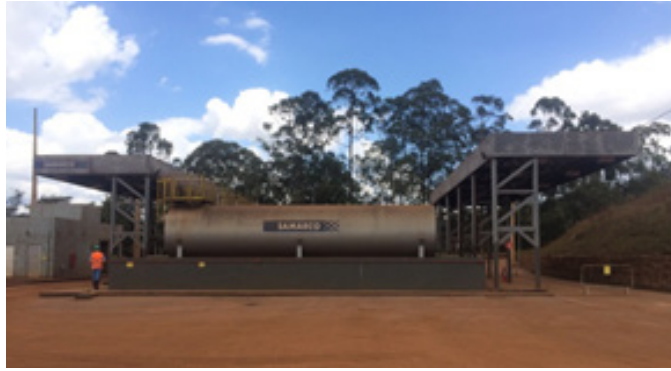
Visão Geral do Posto de Abastecimento de equipamentos de grande porte do Complexo Germano Fonte: Samarco, 2016.
