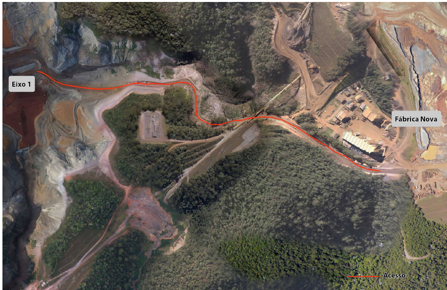
Acesso Fábrica Nova / Eixo 1
