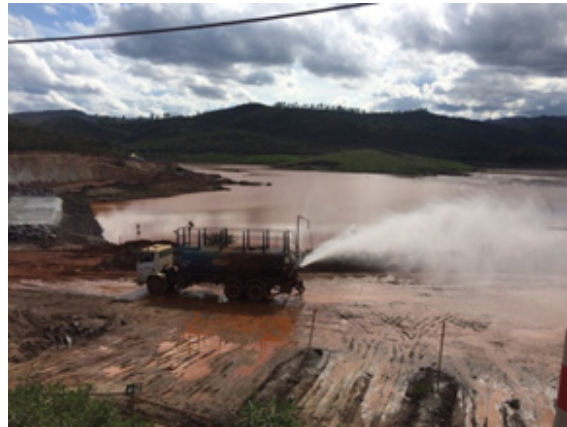
Umectação de via de acesso não pavimentada Fonte: Samarco, 2016.
