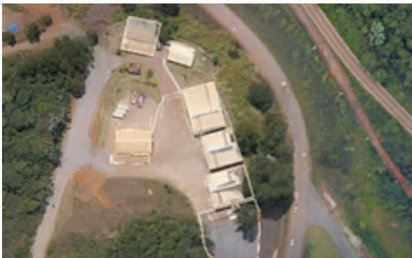
CMD - Central de Material Descartável Fonte: Samarco, 2016
