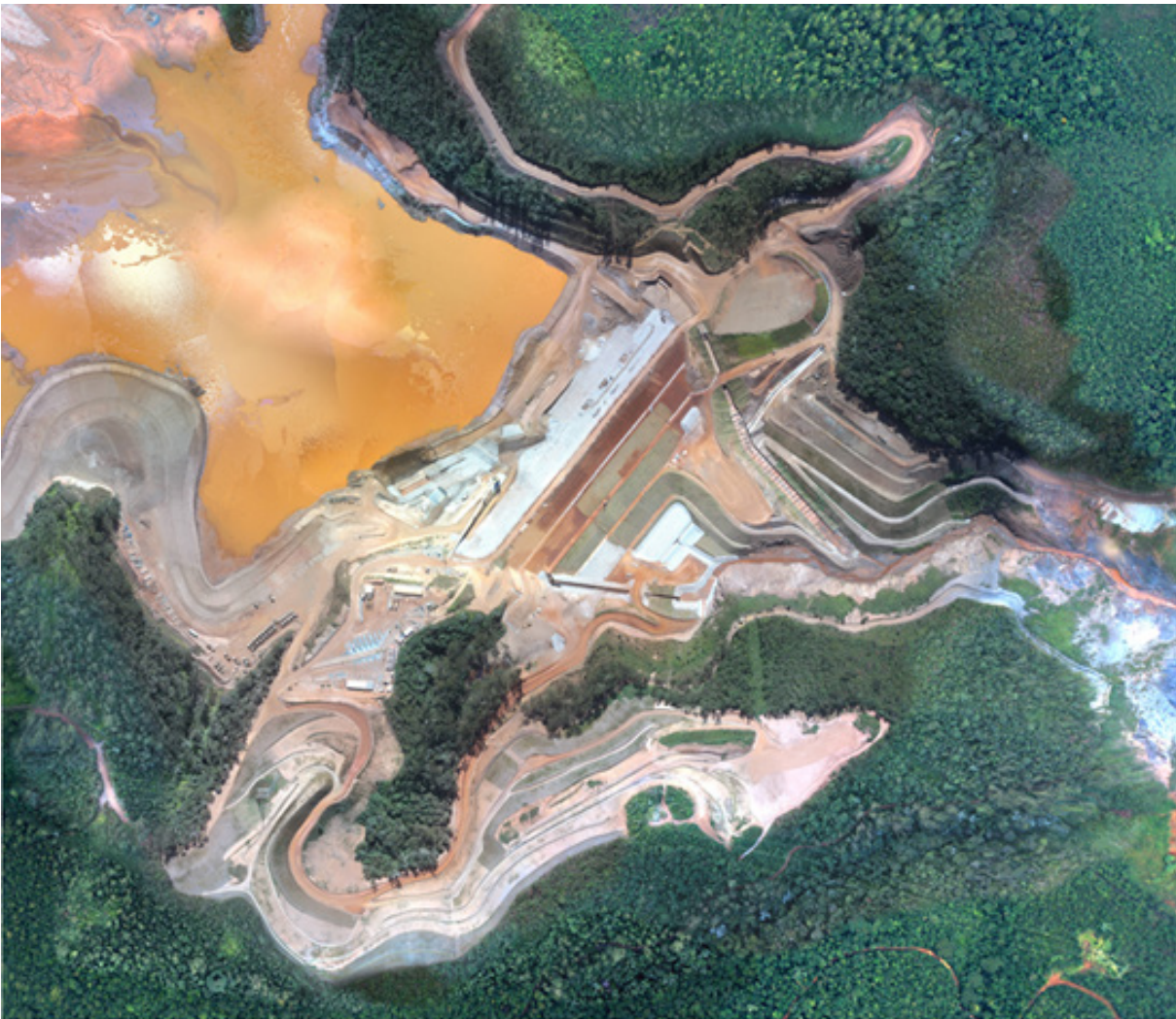
Vista geral da Nova Barragem de Santarém Fonte: Samarco, 2017.
