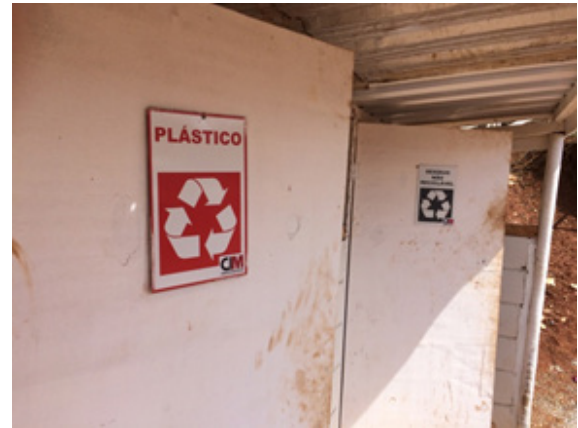
Baias segregadas por tipo de resíduo Fonte: Samarco, 2016.
