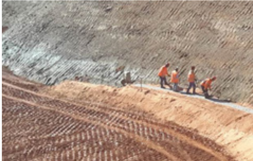
Colaboradores executando limpeza manual da fundação da nova Barragem de Santarém Fonte: BVP, 2016.
