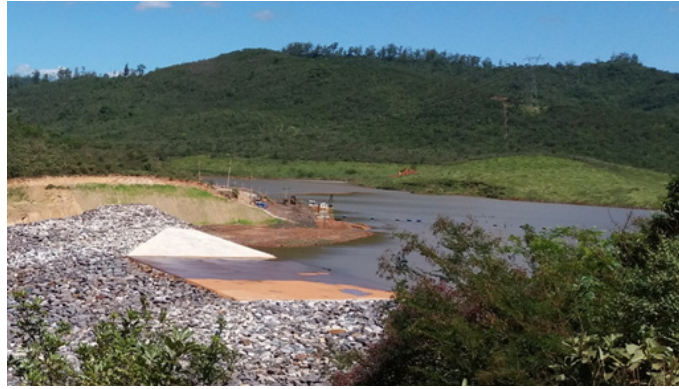
Vista geral do Dique S3
