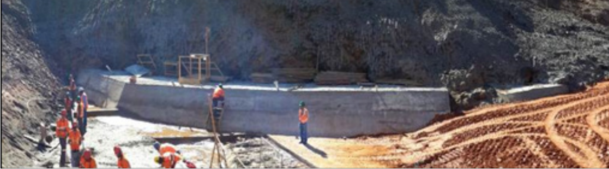
Vista do concreto de regularização em execução na ombreira esquerda do barramento Fonte: BVP, 2016.
