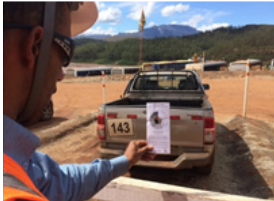
Controle da emissão de fumaça preta através da Escala Ringelmann no Canteiro de Obras próximo à Nova Barragem Santarém Fonte: Samarco, 2016.
