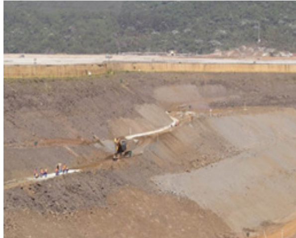
Obras de reforço de jusante dos diques Sela e Tulipa: bermas estabilizadoras
