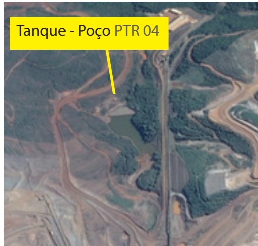
Vista geral do ponto de captação de água para abastecimento dos canteiros Fonte: Samarco, 2016.
