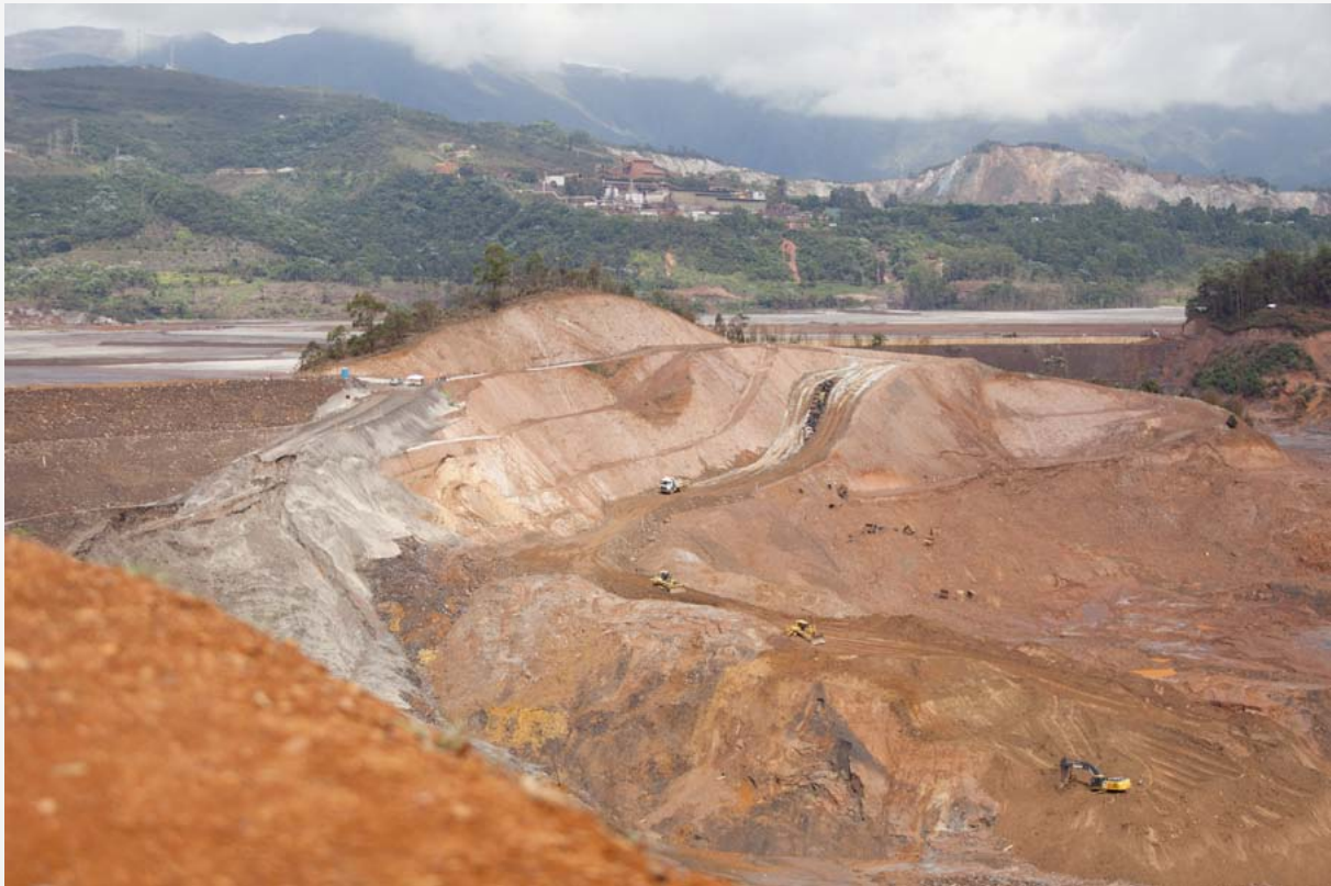
Obras na barragem na Unidade de Germano da Samarco
