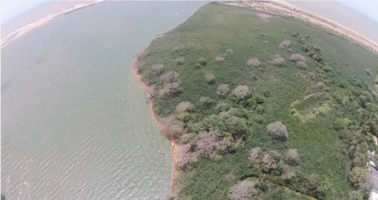
Barreiras de contenção instaladas na Foz do Rio Doce
