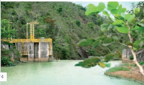
Hidrelétricas próprias garantiram 30,26% da energia consumida em 2006
