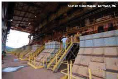
Silos de alimentação - Germano, MG
