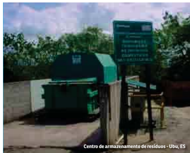
Centro de armazenamento de resíduos - Ubu, ES
