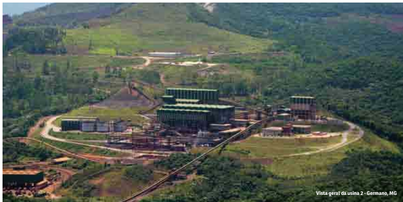
Vista geral da usina 2 - Germano, MG
