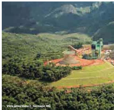
Vista aérea Usina 2 - Germano, MG
