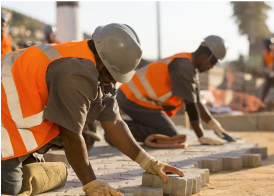
Alternativas para reaproveitamento de rejeitos estão sendo estudadas e implantadas pela Samarco, a exemplo da aplicação de blocos intertravados em Barra Longa
