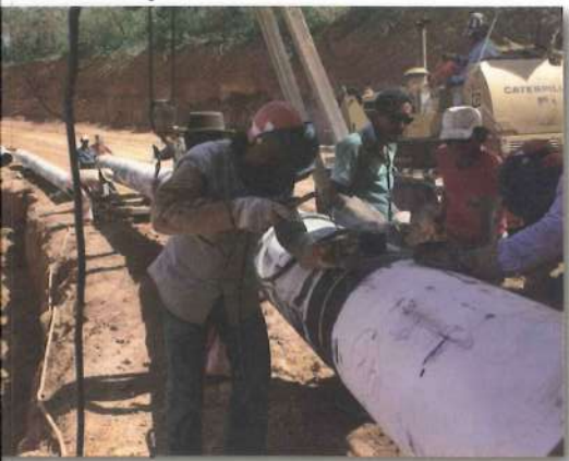
Obras da construção do primeiro mineroduto
