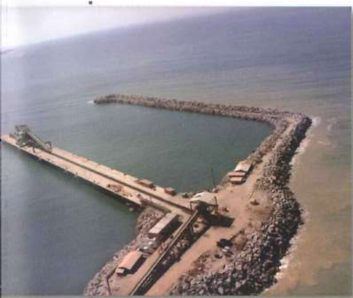
Vista aérea da Usina de Pelotização e do porto de Ubu
