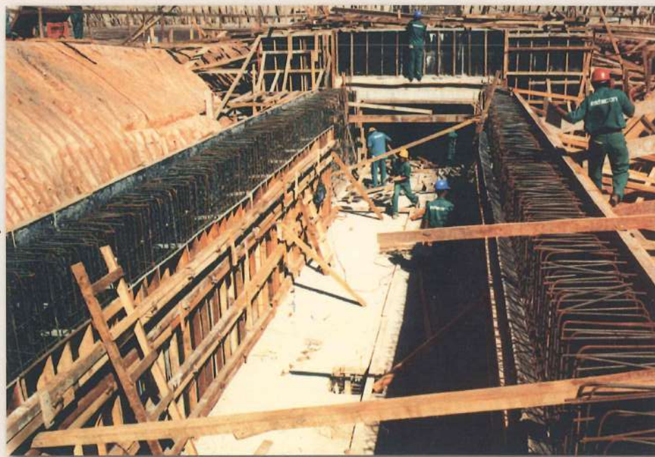
..... Concretagem dos espessadores, projeto de expansão da segunda pelotização, em 1996
