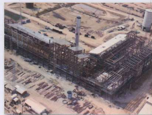
Vista geral das obras da primeira Usina de Pelotização em Ubu
