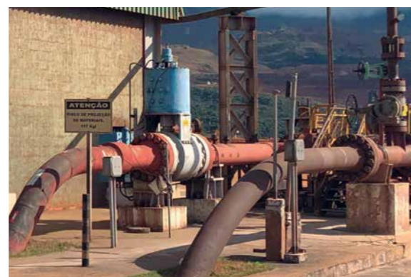
Mineroduto 2: a estrutura interliga os complexos de Germano e Ubu
